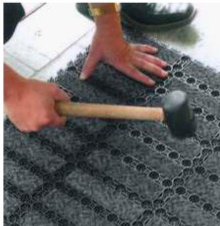
Fácil montagem com sistema de encaixe utilizando martelo de borracha
