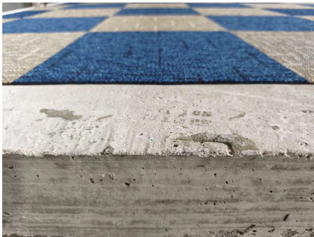
Foto A.4: Montagem da amostra ensaiada.
