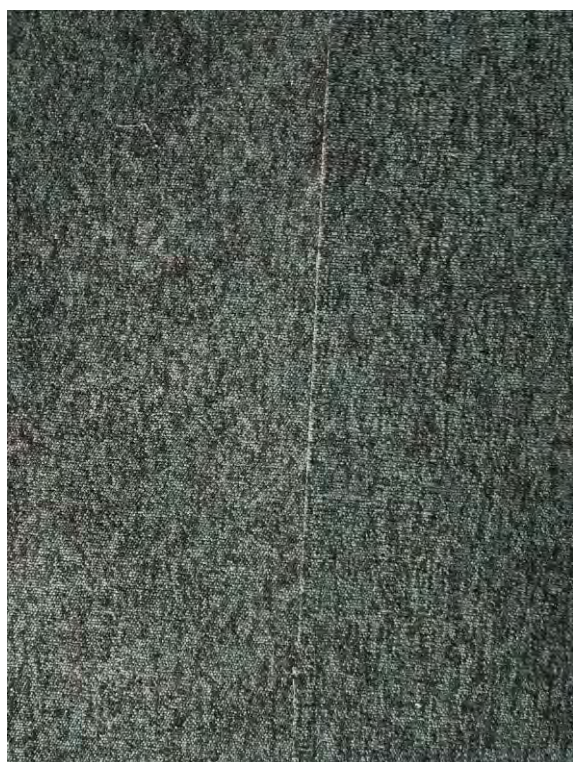
Figura A.2 – Junta entre seções de carpete
